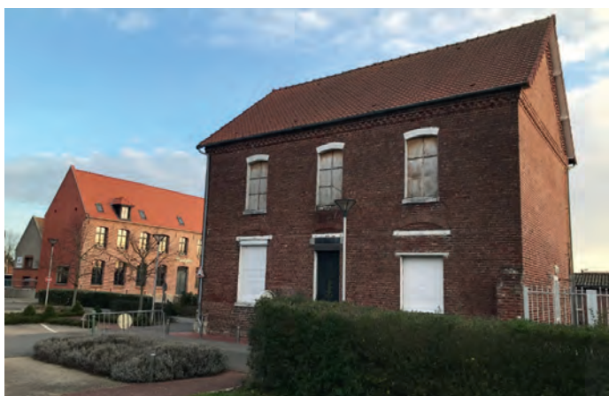
« Les demandes de subventions sont déposées pour la réhabilitation du « logement Alice ».
